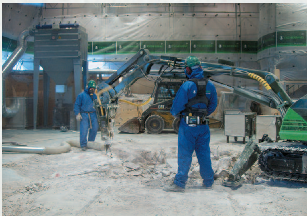
Ophugning af betongulv i DR2 reaktoren.
